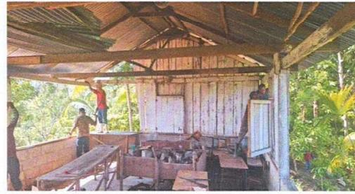
Foto 2: Cambio de estructura y techado de cocina
